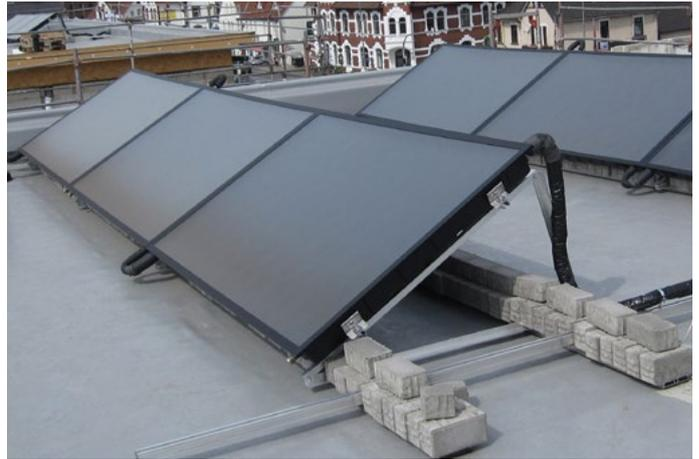
Abb.: CAPITO Solaranlage mit 6 Flachkollektoren CC PCW 252
