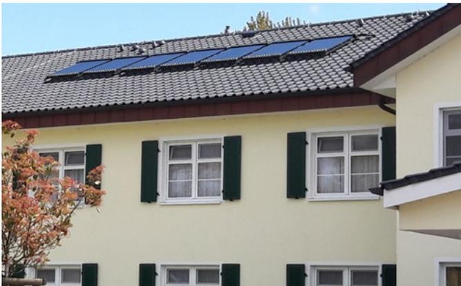
Abb.: Kollektoranlage mit 7 Röhrenkollektoren CC HPV 15
