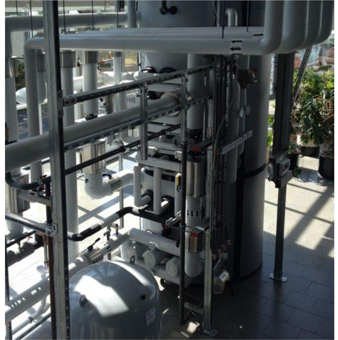
Abb.: CAPITO 3-Zonen-PD 5000 mit Gaskessel, Heizzentrale REHAU AG
